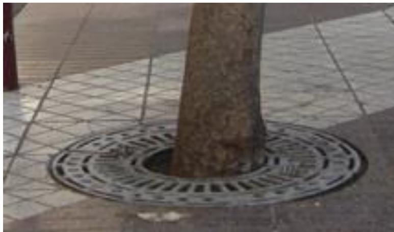
Figura 7: Grelha no centro de ferro fundido.
