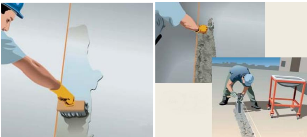
Figura 3: Procedimento para molhar a superfície e Figura 4: Aplicação da argamassa
