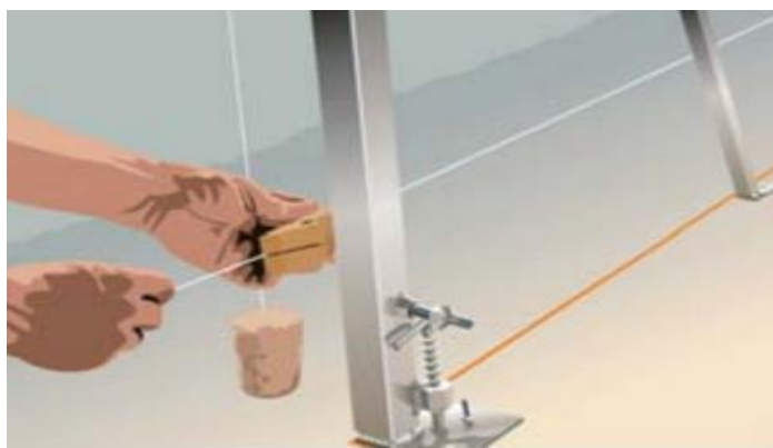
Figura 1: Nivelamento das Fiadas.
