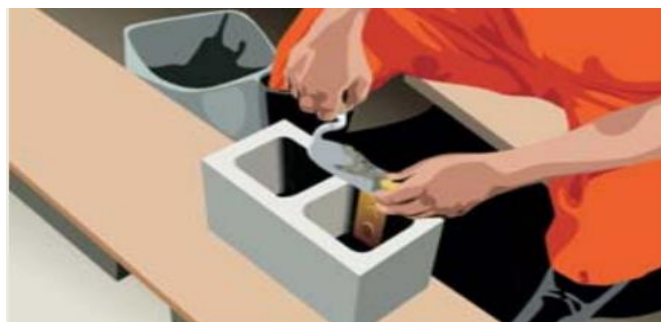
Figura 14: Aplicação das caixas elétricas nos blocos Figura 15: Assentamento do bloco elétrico
