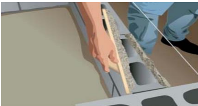
Figura 18: Aplicação da argamassa parede.
