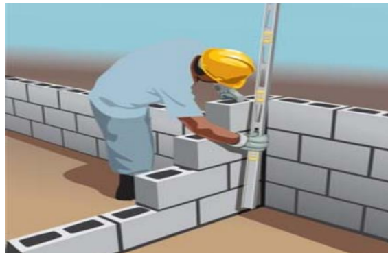
Figura 19: Verificação do prumo e alinhamento da parede.
