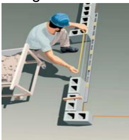
Figura 11: Verificação das aberturas para limpeza
